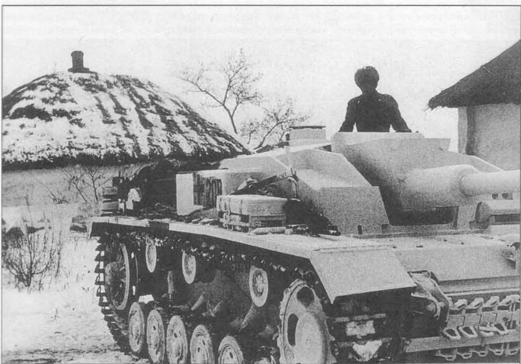
StuG III Ausf F в районе Сталинграда. Машина окрашена белой краской поверх желтого базового цвета. Опознавательные и тактические знаки — черные. Декабрь, 1942 г.
