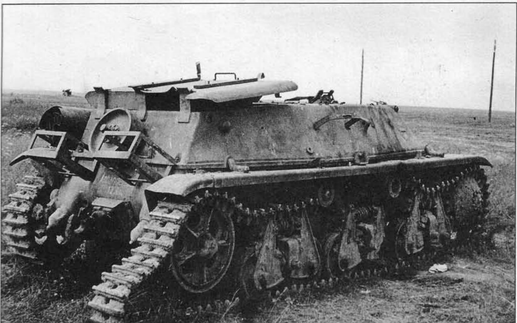
Подвозчик боеприпасов на шасси трофейного французского танка Гочкис Н-35. Лето 1942 г.
