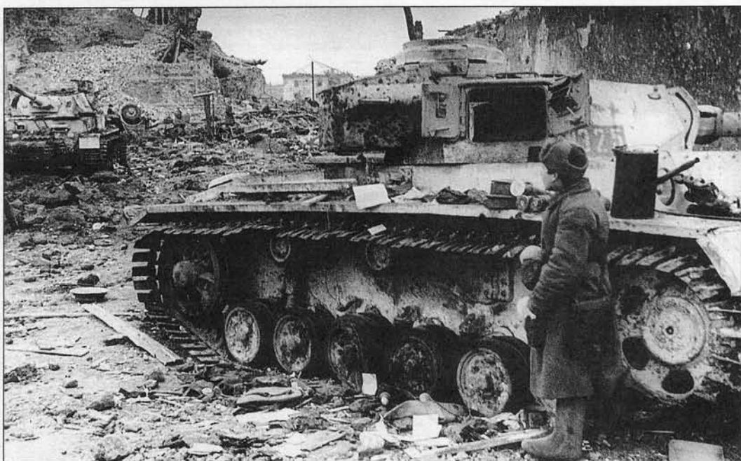
Танк PzKpfw III Ausf L, брошенный в районе Великих Лук. Машина окрашена белой краской поверх базового Schwarzgrau и имеет специальные зимние гусеницы, понижающие давление на грунт. Весна 1943 г.
