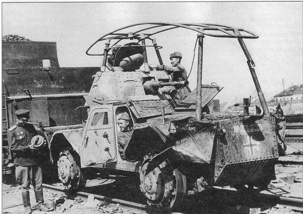
Бронеавтомобиль «Панар» Р 204(f) в железнодорожном варианте, захваченный советскими войсками. 3-й Украинский фронт, станция Раздельная. Май, 1944 г.
